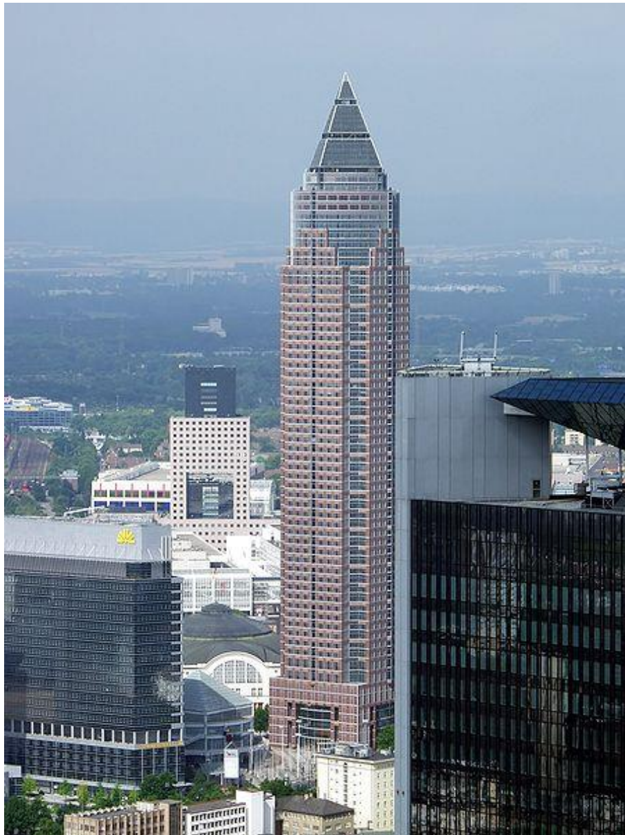
Bild 1.1 Messturm von der Aussichtsplattform des Maintowers 1
